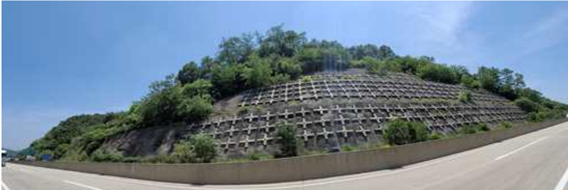
영천절토 22 (관리이정 27.484~27.674km / 3공구 STA.11+470~11+660)
