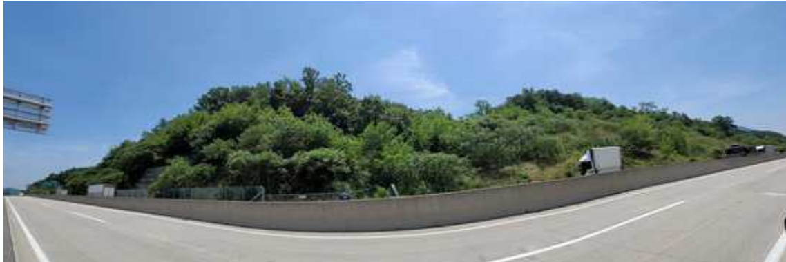
영천절토 21 (관리이정 26.654~27.034km / 3공구 STA.10+640~11+020)
