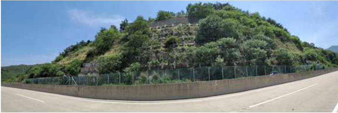
영천절토 19 (관리이정 24.754~24.974km / 3공구 STA.8+740~8+960)
