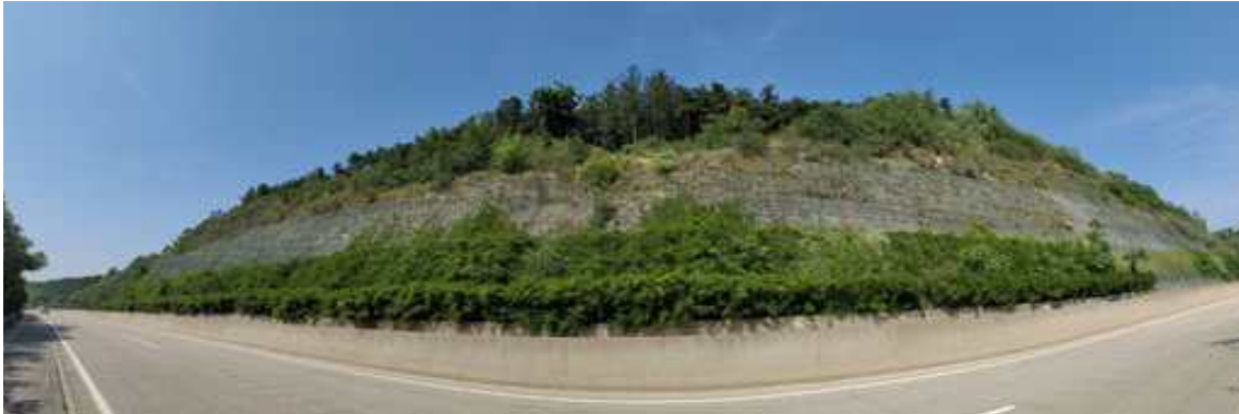
상주절토 09 (관리이정 14.494~14.934km / 2공구 STA.7+100~7+540)
