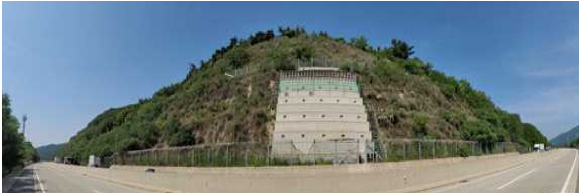
상주절토 14 (관리이정 17.304~17.504km / 3공구 STA.1+290~1+490)
