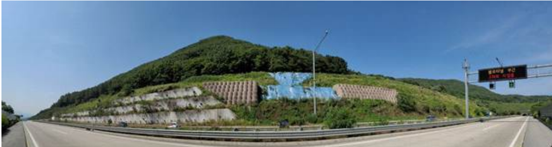
상주절토 16 (관리이정 21.194~22.054km / 3공구 STA.5+180~6+040)
